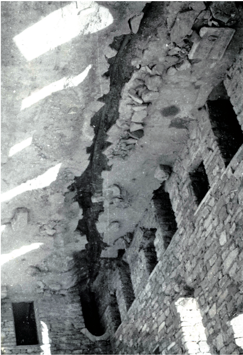
Նկ. 5. Վանախցերի բակով անցնող ջրատար համակարգը
