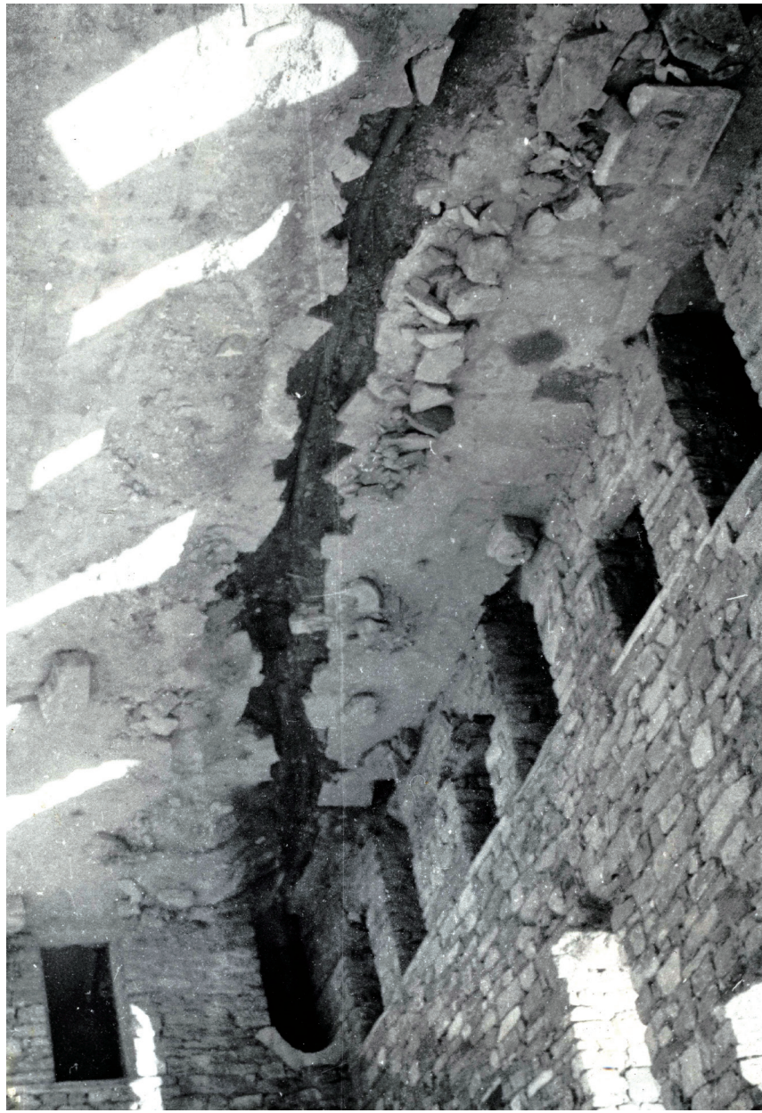
Նկ. 5. Վանախցերի բակով անցնող ջրատար համակարգը
