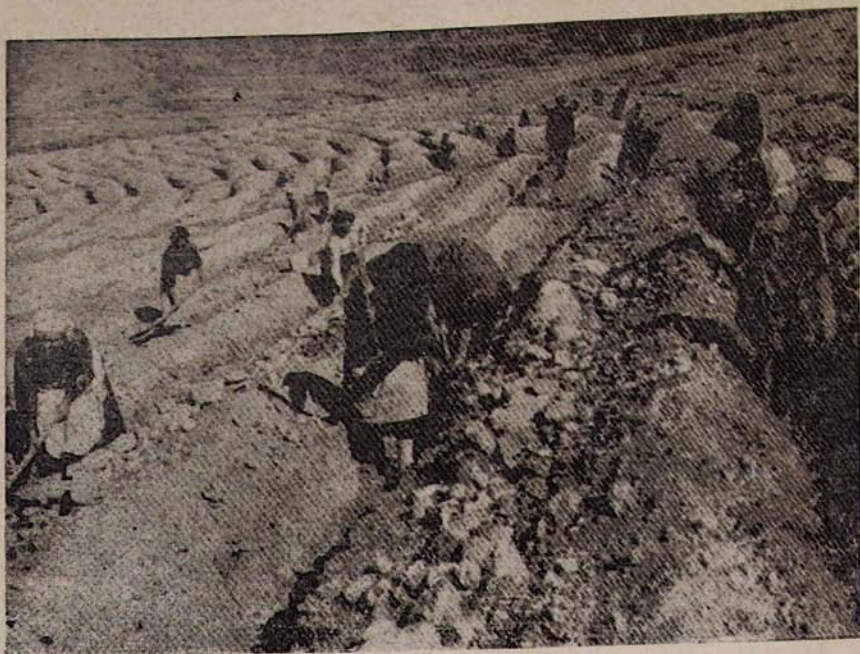
Рис. 1. Подготовка почвы под лесокультуры траншейным способом по системе, разработанной Минлесхозом Арм. ССР. Саритагские склоны г. Еревана. 1950 год.
