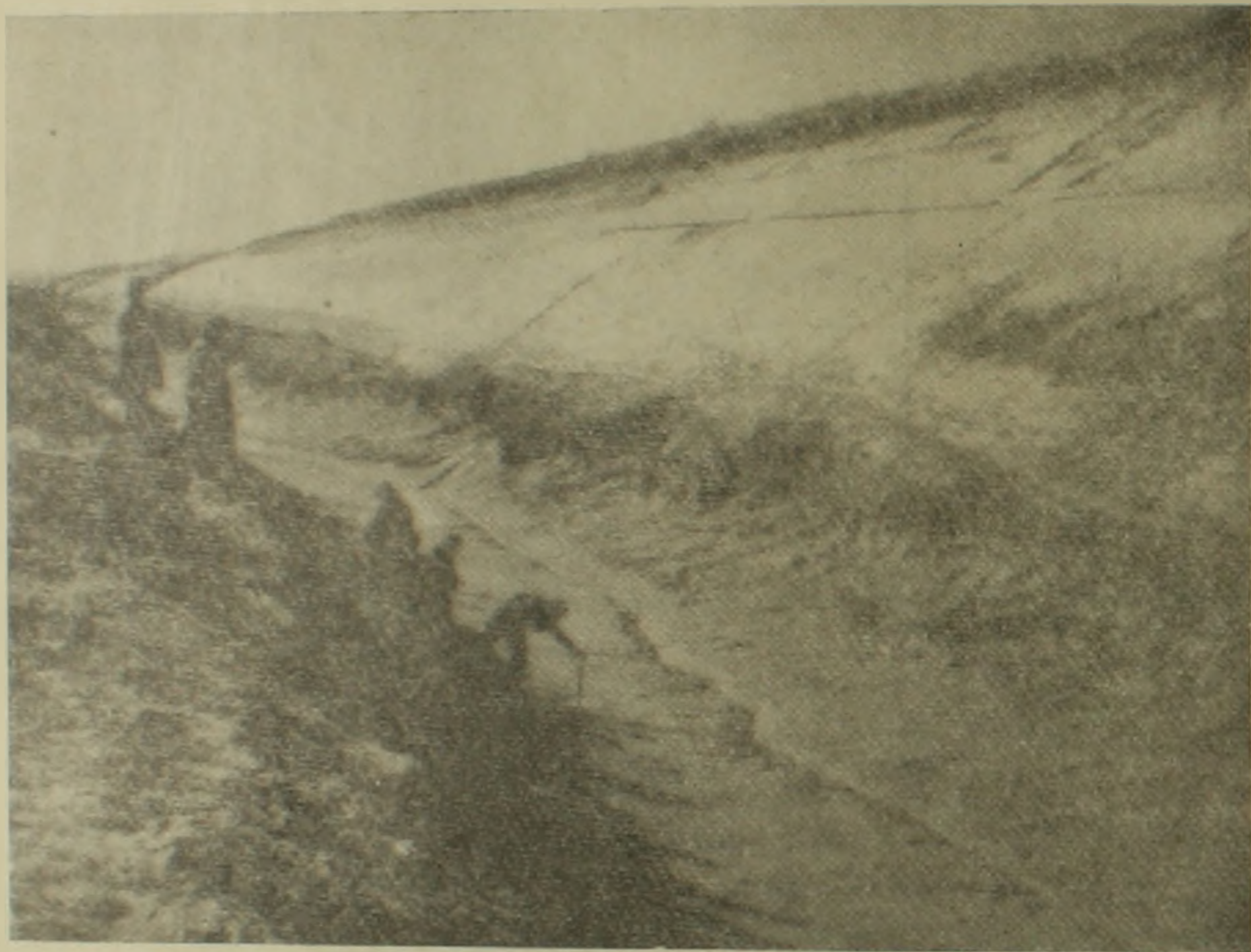
Фиг. 6. Разжижение откоса из песчаного грунта.
