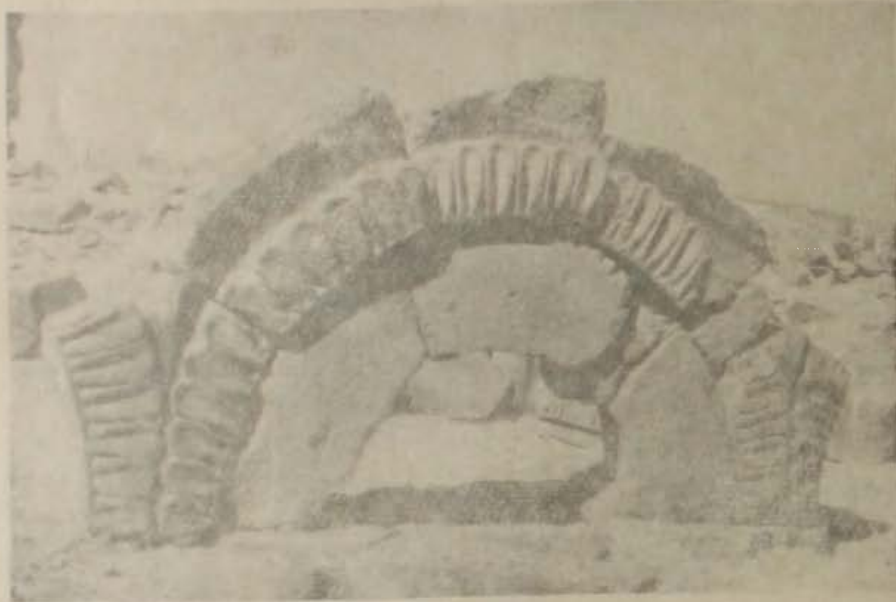
Նկ. 11. երկրորդ յարուսի կամարաղեղը և լուսամուտի վերին մասը:
