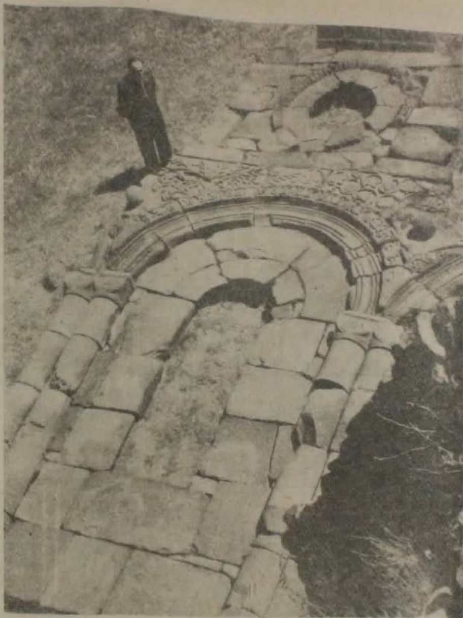
Նկ. Ծ. Առաջին յարուսի նիստերից մեկի բարերի համադրումը տեղում:
