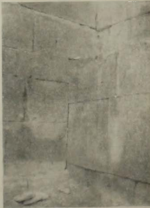
Նկ. 4. Ձվարթնոցի արևելյան հավելվածի և տաճարի հիմնապատերի կցման հանդույցը (հարավ-արևմտյան անկյունը, ներսից):
