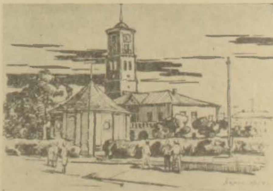
Польская ратуша, Впереди Армянский колодец после ремонта.
